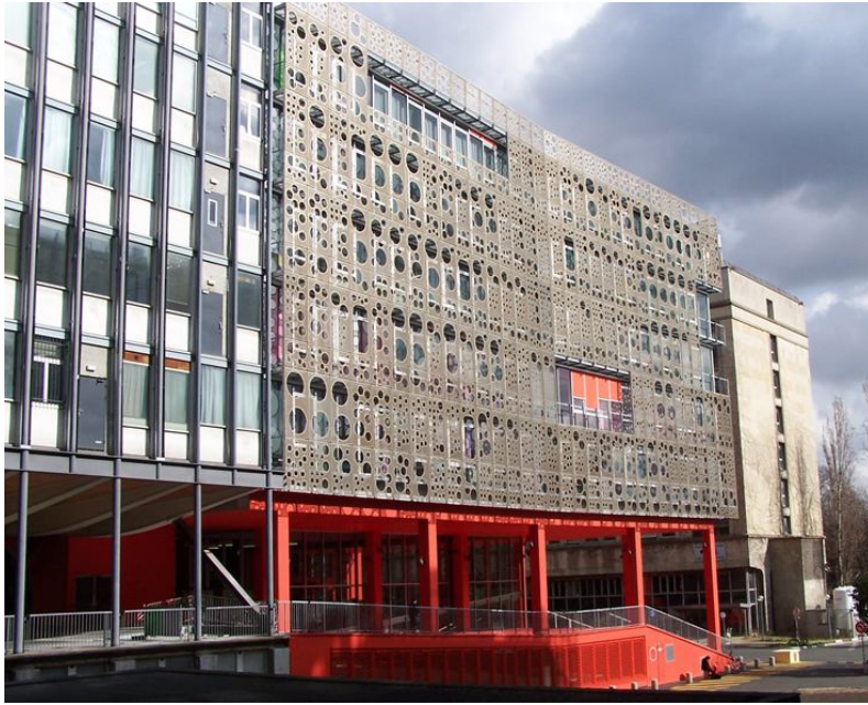
Fig. 1. Vista esterna dell'edificio. Continuità della facciata del complesso preesistente con la nuova realizzazione
