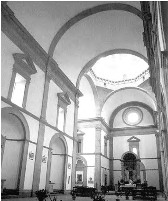
Fig. 15 – Chiesa di Santa Maria delle Grazie al Calcinaia a Cortona, veduta della navata verso il transetto.
